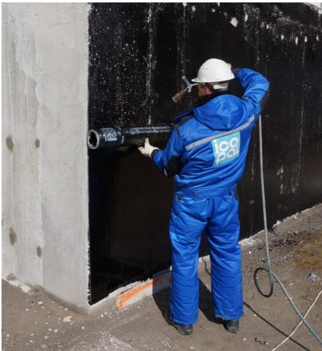
Рисунок 56 - Наплавление на стену здания
