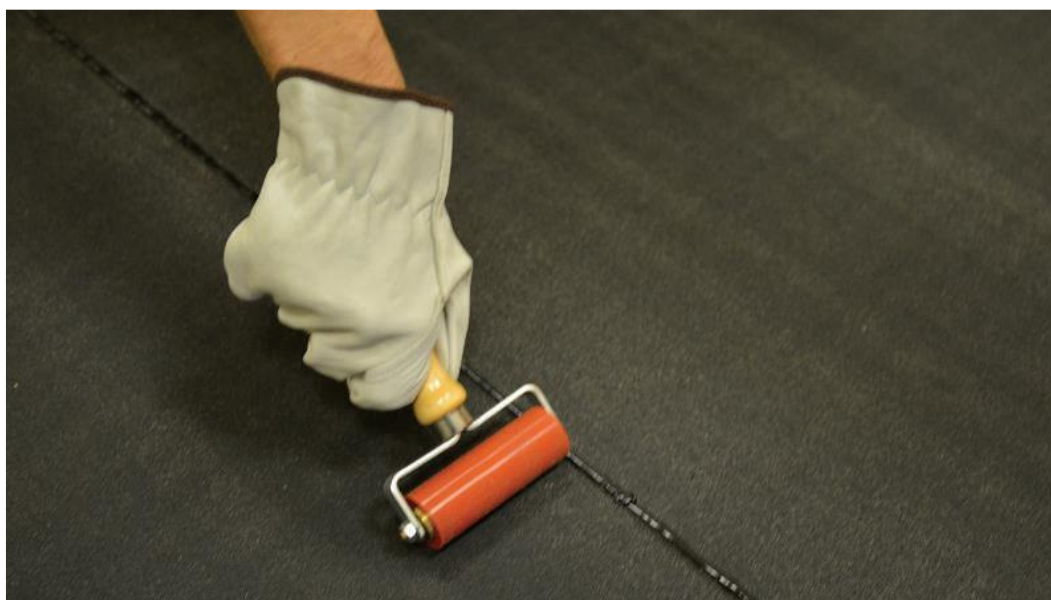
Рисунок 50 - Использование прикаточного ролика
