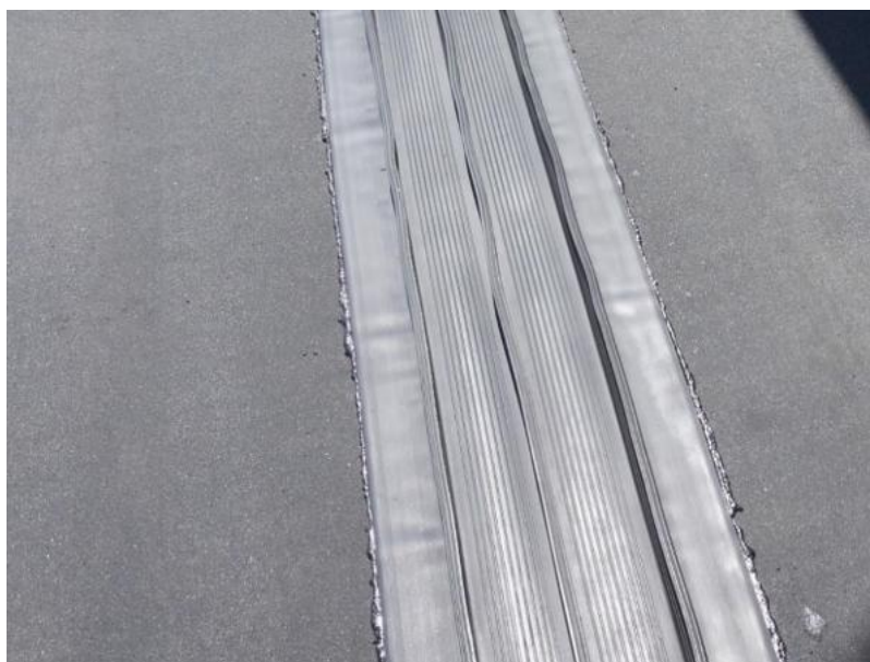
Рисунок 63 - Соединение Гидрошпонки ИКОПАЛ ХН-Б 200/25 с УЛЬТРАНАП
